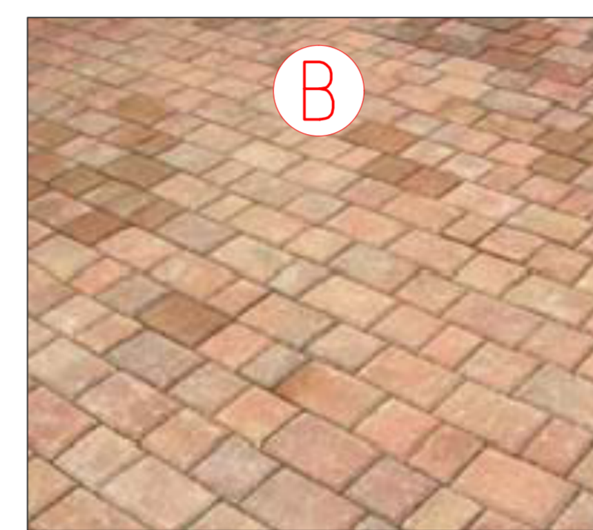
PAVIMENTAZIONE del CAMMINAMENTO PUBBLICO in MASSELLI AUTOBLOCCANTI
