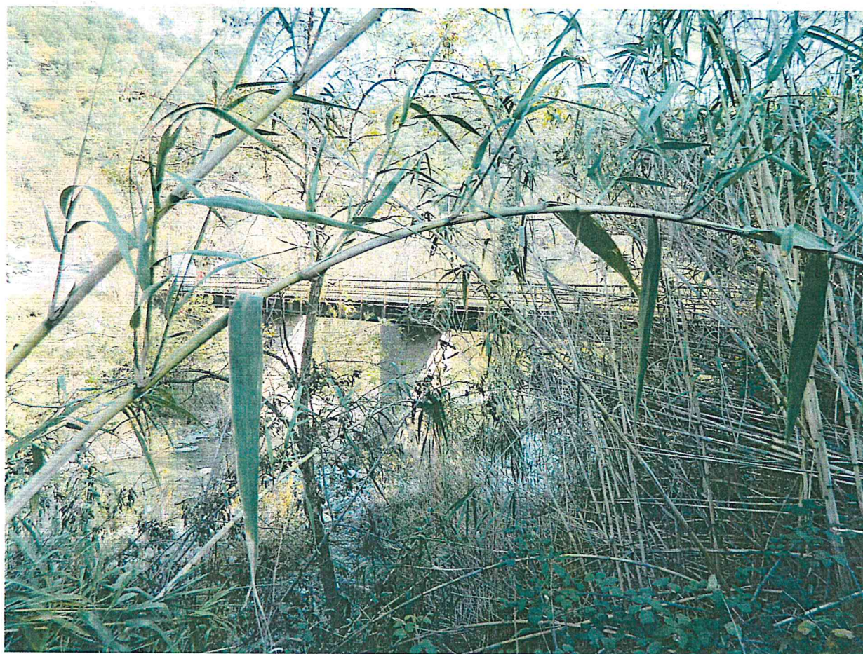
Foto 5: VISTA DEL PONTE DI ACCESSO
